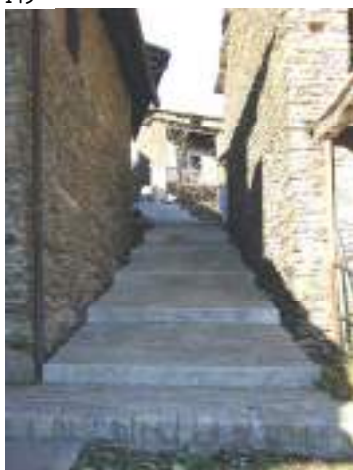
149. percorso esterno sistemato con rampa in pietra: da notare lo stacco dalle murature laterali sistemato a canaletta per il deflusso dell'acqua
